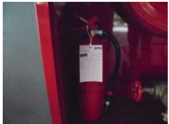
รูปที่ 28 เครื่องดับเพลิงเคมีมือถือ
