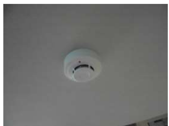
รูปที่ 30 ติดตั้งอุปกรณ์แจ้งอัคคีภัย
