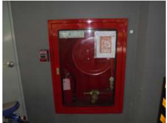
รูปที่ 26 ตู้สายฉีดน้ำดับเพลิง
